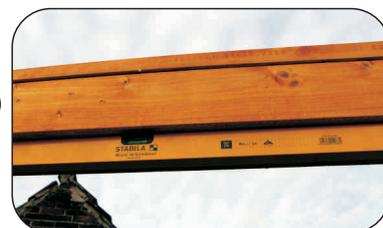
Jetzt können die Kopfbänder mittels je 4 Tellerkopfschrauben angebracht werden.
