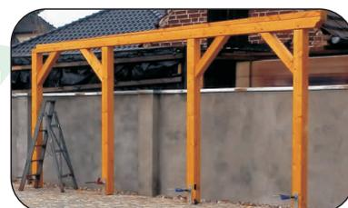
Die Löcher für die Befestigung der Pfosten an den Pfostenträgern mit einem 6mm Bohrer vorbohren und die Schlüsselschrauben 10x60(10x70) einschrauben.
