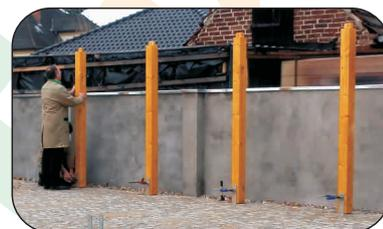
Nun die Rähm mit Keil auf die Gewindestagen der Pfosten oben auflegen und an die Pfosten mit Scheiben und Muttern M12 festschrauben. Alle Pfosten ausrichten (Abstand und Waage prüfen! Hier besonders auf die Abstände im Bereich der Tür und der Geräteraumwände achten!) Die Unterkante der Rähm muss genau in Waage ausgerichtet werden. Die Pfosten müssen ca. 2cm über dem Boden sein.
