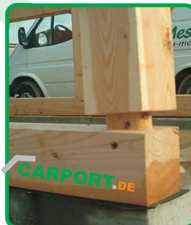
Wenn Sie die Hölzer ineinander gesteckt haben, schlagen Sie den Holznagel ein. Nehmen Sie einen Fäustel oder einen großen Schlosserhammer (3-5 kg) mit glatter Bahn. Um das Einschlagen zu erleichtern, tauchen Sie die Spitze des Holznagels in ein Spülmittel. So gleitet er besser durch das Holz. Holznägel bleiben sichtbar und werden nicht abgeschnitten.
