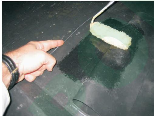
Kontur mit Dichtmasse VB-9510 abspritzen .
