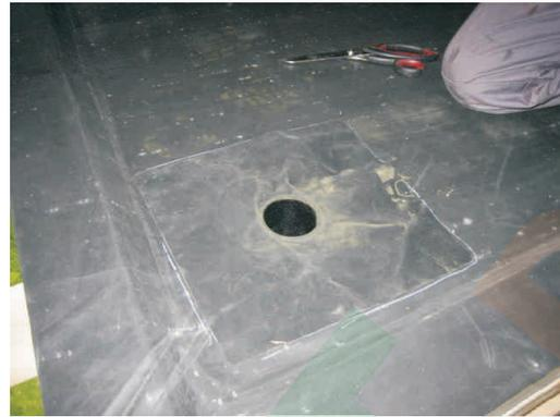
Unterseite des Flansches (4 cm des Randes freihalten) und Oberseite der Plane (4 cm von der Kreidenkontur freihalten) mit BA-2004 Kontaktkleber rundum einrollern, trocknen lassen und andrücken.
