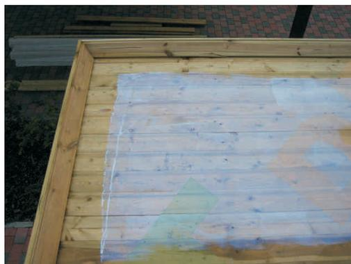
4. Die Plane gleichmässig in den nassen Kleber zurückschieben und mit einem festen Besen an den Untergrund anfeigen. Die innere Struktur der Plane wird sich in den folgenden Monaten formieren. Leichte Falten entfernen sich damit von selbst.
