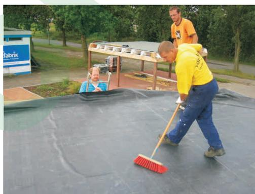
5. Den Planenrand zurückschlagen. Die Plane und den Holzuntergrund dünn mit BA-2004 Kontaktkleber einrollen und trocknen lassen. Bei Berührung mit dem Finger dürfen keine Kleberfäden gezogen werden.
