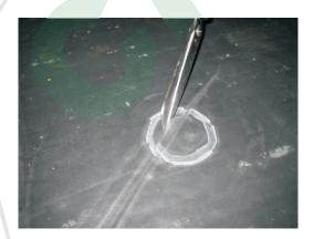
Gulli mit Abflussrohr in Position bringen und Kontur des Flansches mit Kreide auf der Plane anzeichnen.
