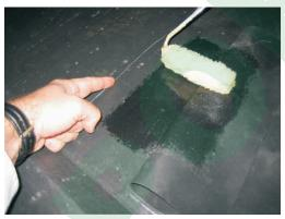
Kontur mit Dichtmasse VB-9510 abspritzen .
