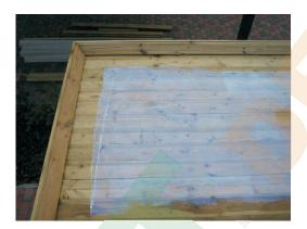
4. Die Plane gleichmässig in den nassen Kleber zurückschieben und mit einem festen Besen an den Untergrund anfegen. Die innere Struktur der Plane wird sich in den folgenden Monaten formieren. Leichte Falten entfernen sich damit von selbst.
