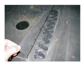
Oberfläche anrollern. Es soll mindestens 1,5 mm Dichtmasse zwischen den beiden EPDM-Schichten zurückbleiben. Überschüssige Dichtmasse entfernen.
